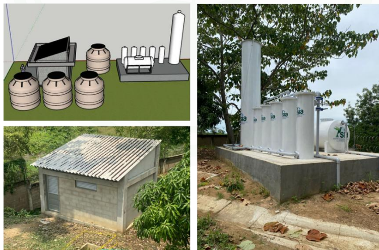
Figura 43. Sistema de agua potable Sahagún
