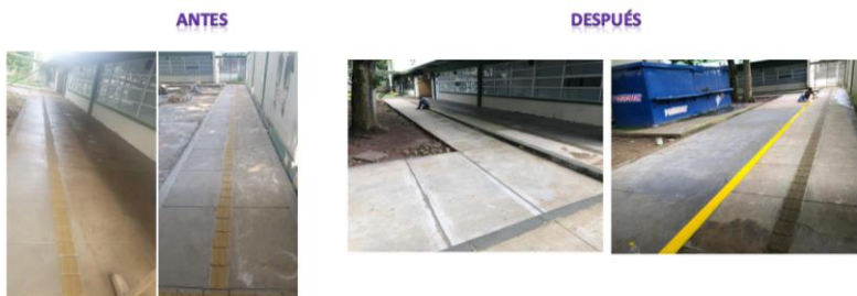
Adecuación y construcción de andenes Fase 1 de la Unicor Sede Berastegui.
