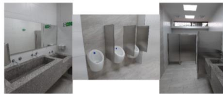
Adecuacion y remodelacion de baños en la Biblioteca "Misael Diaz Urzola" de la Universidad de Córdoba, sede Montería.
