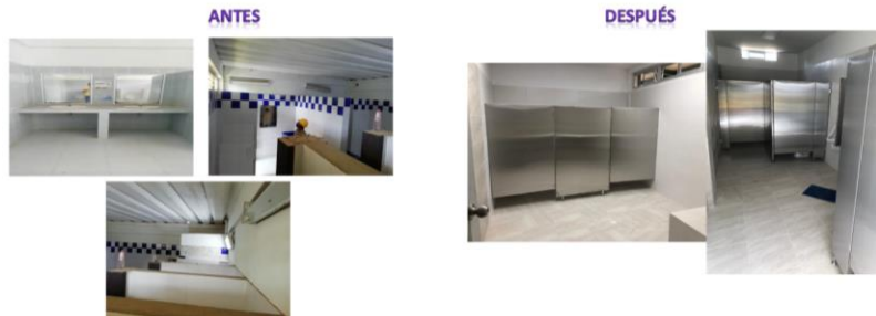
Construcción de una unidad sanitaria para la Clínica de Pequeños Animales, remodelación y adecuación de una unidad sanitaria de hombres en el Bloque 13 de la Unicor Sede Berastegui
