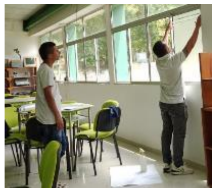
Instalación de película protectora en todas las ventanas
