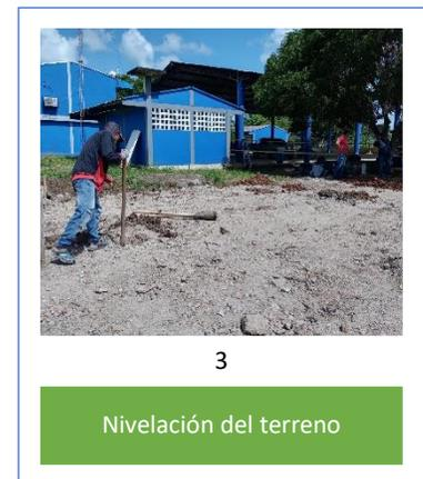
**Paso 3.** Luego, la EMPRESA CONTRATADA debe realizar el trazado del área a construir; este trazado consiste en delimitar un área de 50 m<sup>2</sup> con 10 m de largo y 5 m de ancho, esta área debe quedar centrada con respecto al área antes delimitada tal como se, muestra en la ilustración 1.
