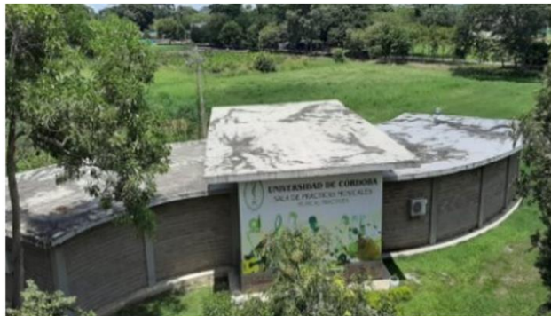
Mantenimiento de cubiertas en el Edificio de Prácticas Instrumentales y Artes Escénicas B12 de la Universidad de Córdoba, Sede Montería. $40.500.000
