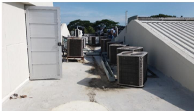
Mantenimiento de cubiertas en el Edificio de Educación B13 de la Universidad de Córdoba, Sede Montería $75.679.547
