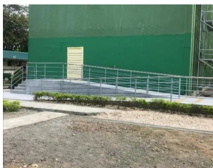
Figura 9.18: Rampa construida para salida de emergencia.
