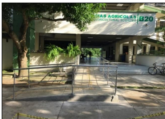
Figura 9.9: Rampas construidas para movilización de minusválidos.
