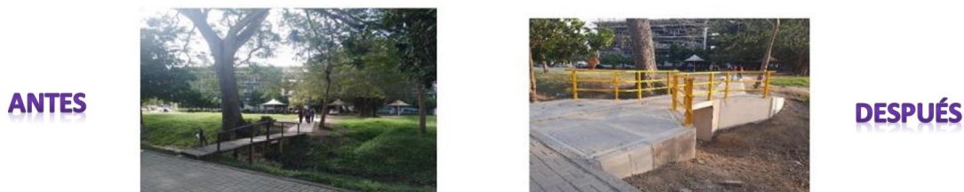
Figura 9.14: Box-Couvert peatonal Sede Montería.
