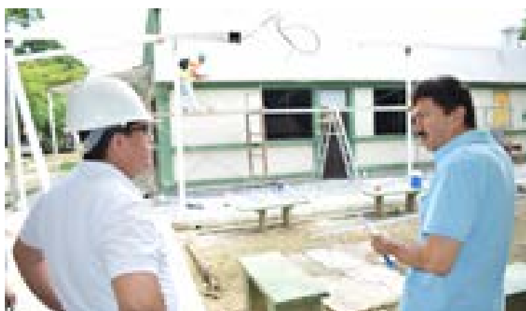
Los laboratorios de la facultad de Ciencias Básicas contarán con nuevas cubiertas.
