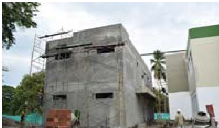
Se construye el nuevo laboratorio integrado de Ingeniería Industrial.
