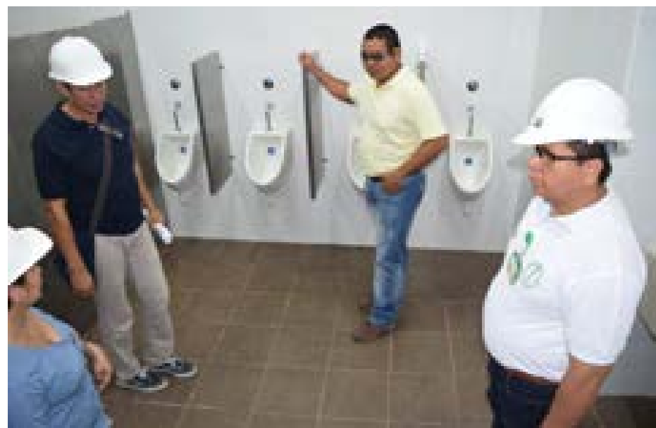
Para superar el déficit de baños en la Institución, la administración ha invertido recursos en la construcción de nuevas baterías sanitarias en varios puntos del campus central.
